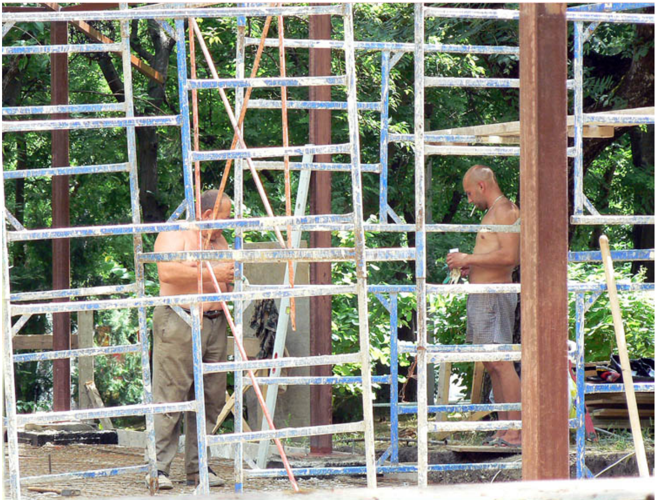
15 июня 2011 года, около 16.00. Парк им.Ленина. Строительство кафе. Надеемся, без нарушений законодательства. Рабочие работают и курят. Хозяйка решает вопросы по телефону и контролирует процесс.
